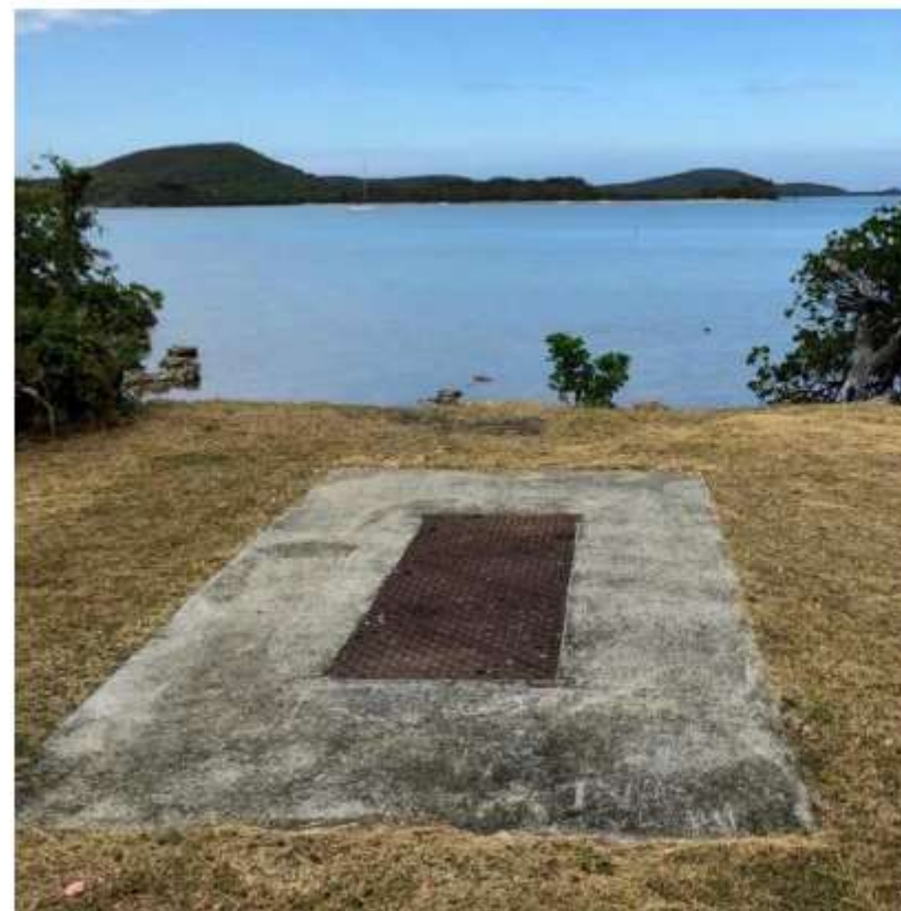
Figure 20 : Photo de la BMH existante du câble sous-marin Gondwana 1, à Ouémo
